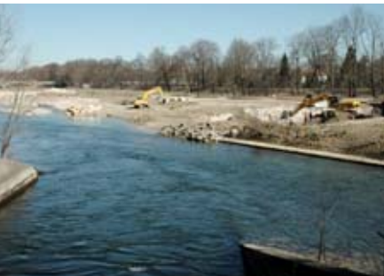
Einleitungsstelle während der Umbauphase
