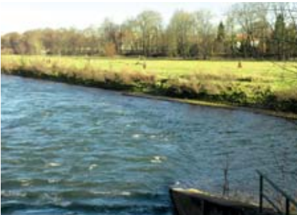
Einleitungsstelle Isarkanal in die Isar vor Umbau
