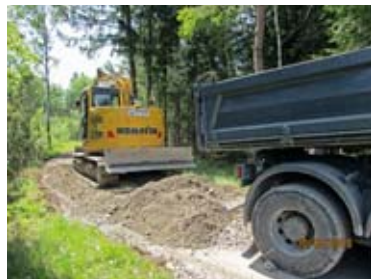
Um möglichst wenig Grund zu beanspruchen, muss für den Neubau des Ersatzweges „Vor Kopf“ gearbeitet werden.
