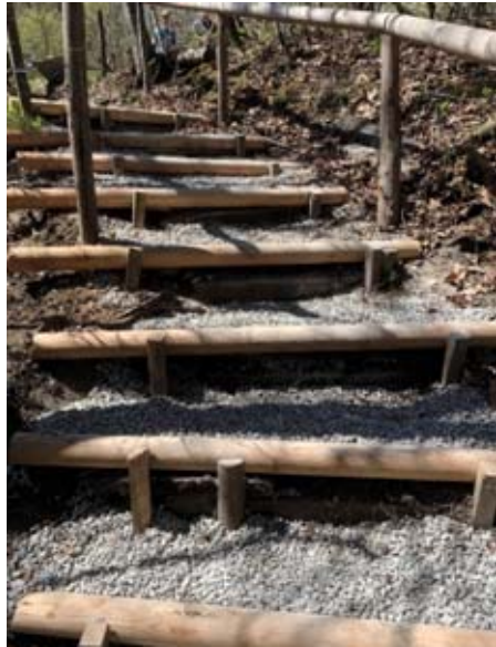
Treppe Riemerschmidpark vor und nach Instandsetzung
