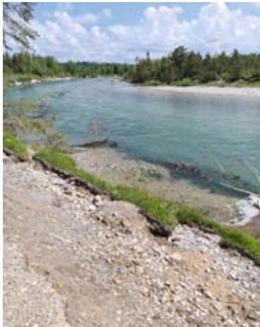
Mit dem ersten Hochwasser nach Ende der Maßnahme brechen wertvolle Trockenstandorte mit dem Ufer ins Gewässer. Foto: © WWA Weilheim
